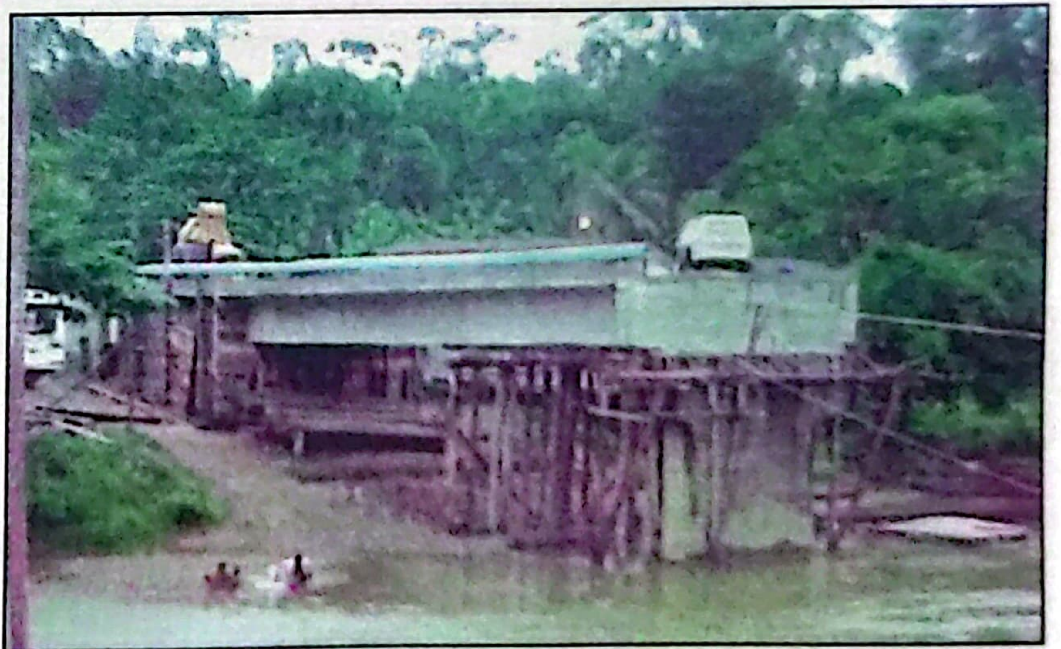
Puente sobre el Rio Quito, este puente une la población con la red de vía nacional.
