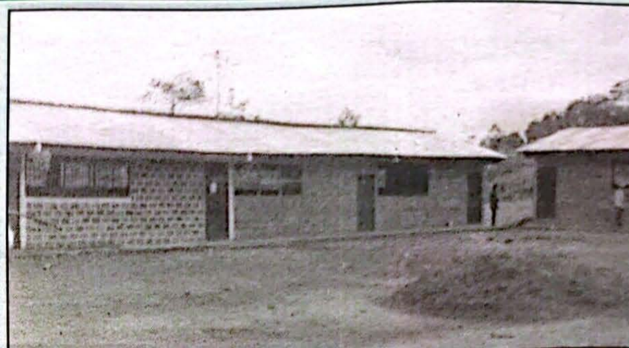
Construcción del Colegio Julio Mejía Velez
