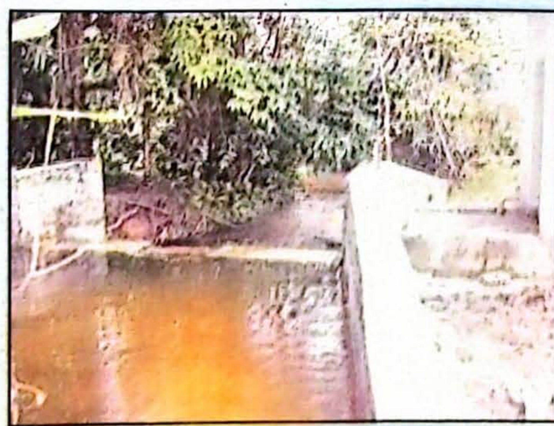
Bocatoma acueducto de Managrú
