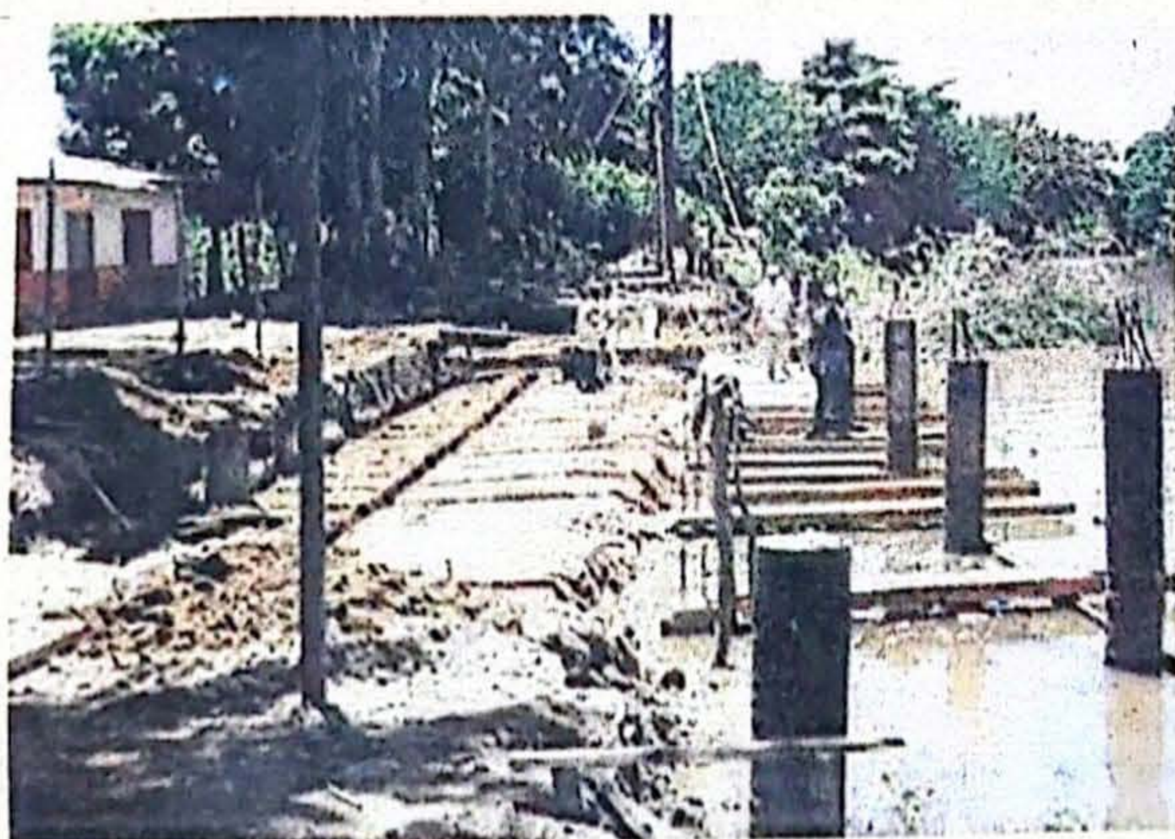
Aspecto de la construcción del muelle de acceso a Unguía
