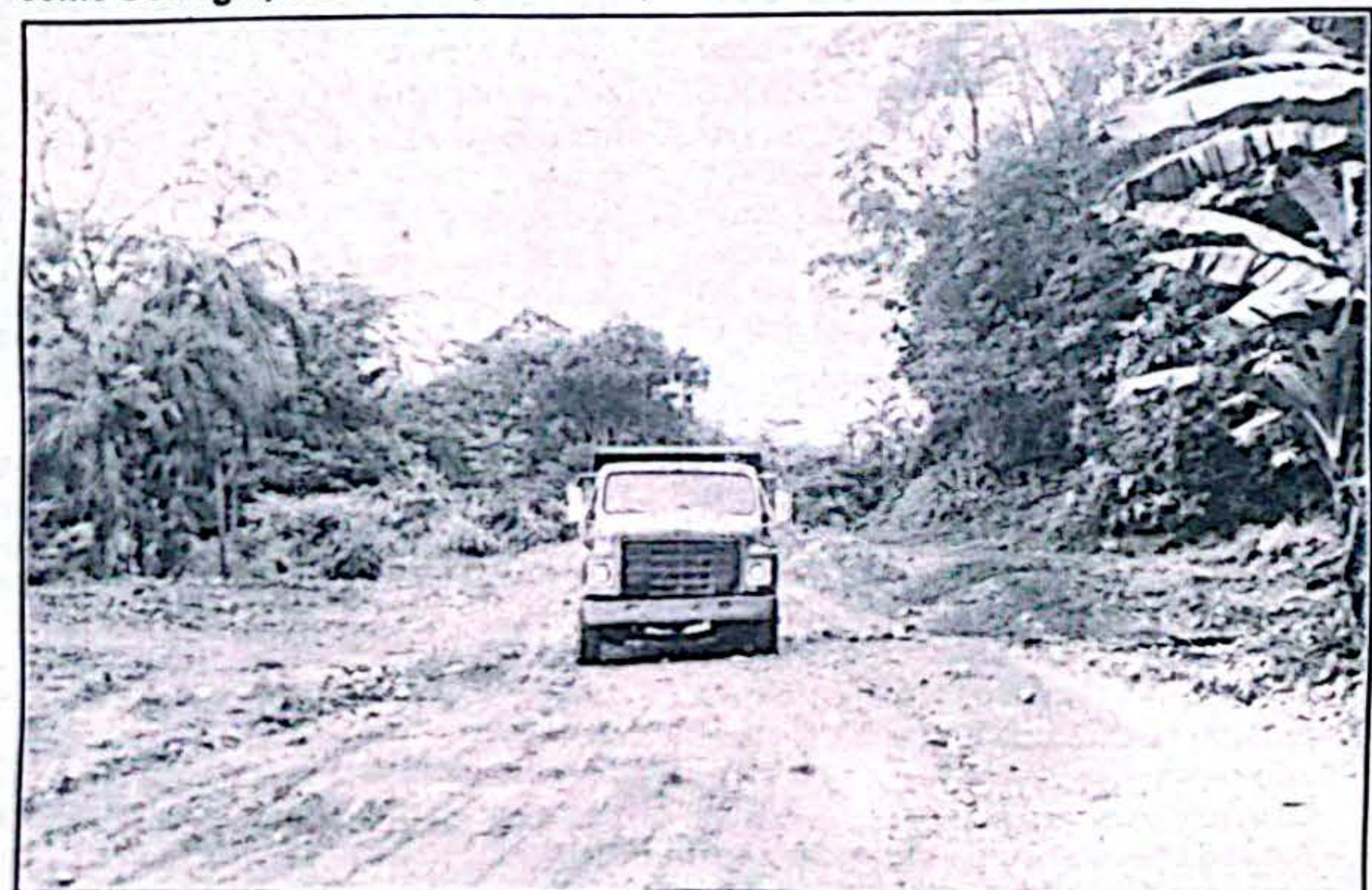
En asocio con el Distrito de Obras No. 9 y obreros del municipio se trabaja a ritmo paísa en la pavimentación de los dos primeros kilómetros hasta las Animas.
