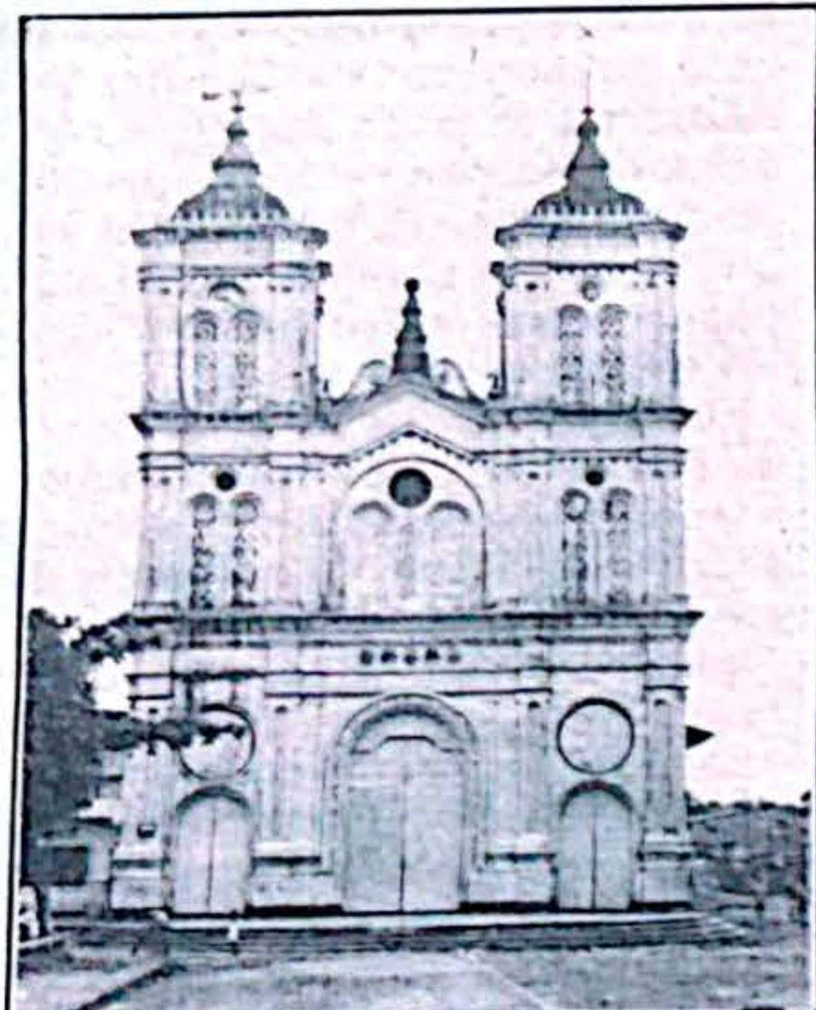
La iglesia de Tadó, una joya de la Colonia es una de las más antiguas del Chocó, se encuentra bastante deteriorada.
