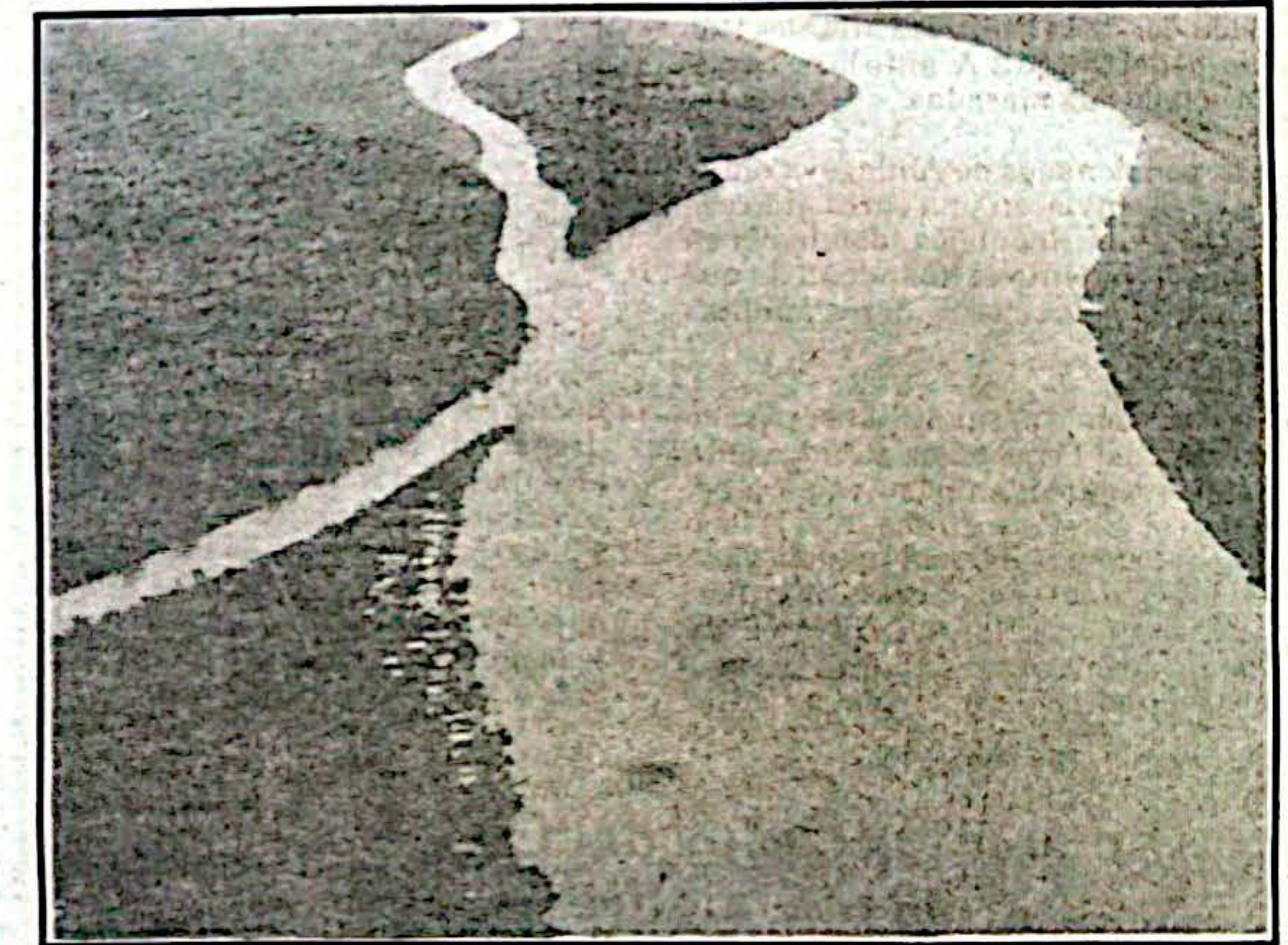
Por Cacarica se construirá el puente sobre el río Atrato de 1,3 Km de longitud
