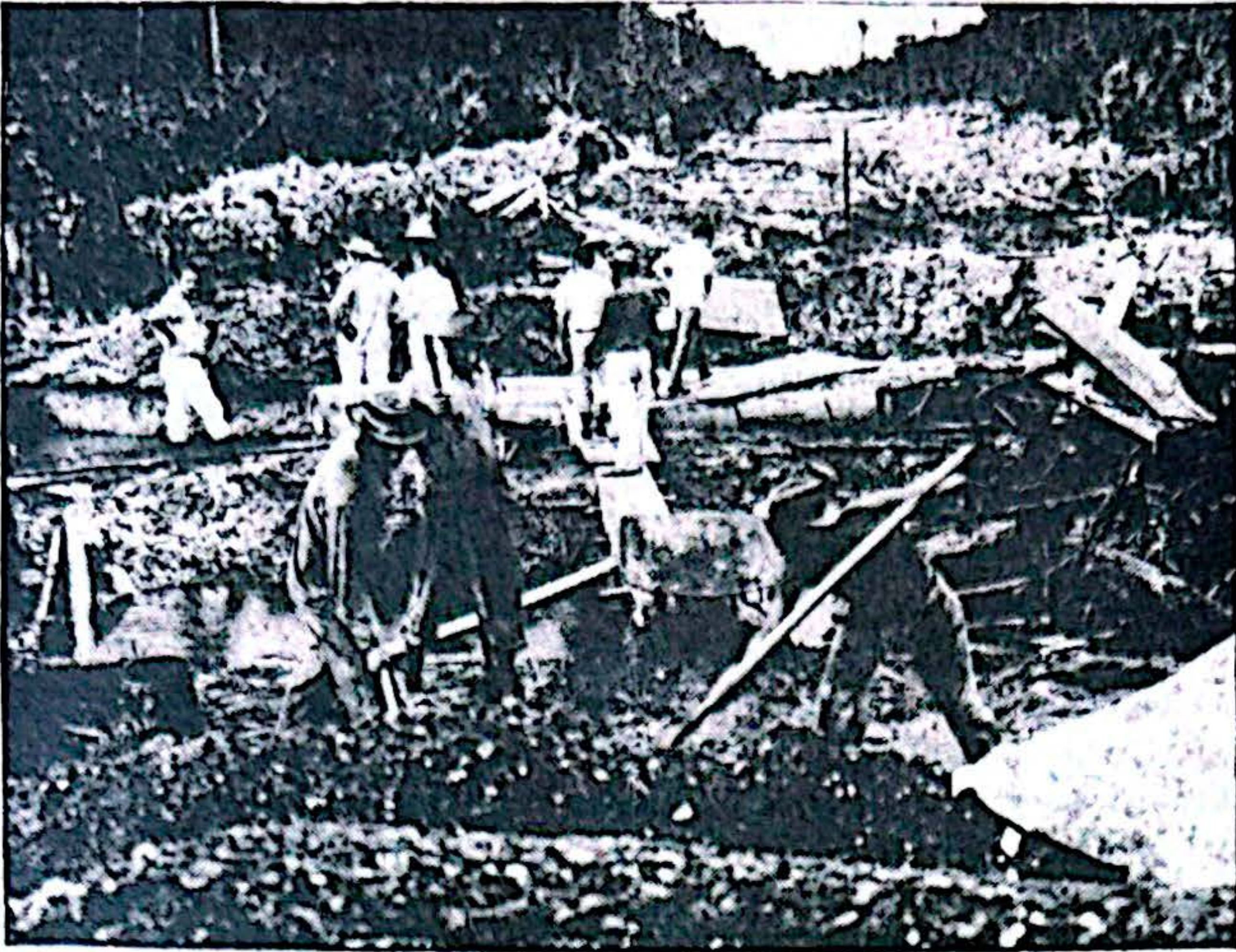
A PASO DE TORTUGA. Muy lentos los trabajos en el tramo de la carretera a Nuquí, sector Río Pató-Río Baudó. Los aportes de la Nación son insuficientes. Se requiere mayor inversión y nuevas fuentes de trabajo.
