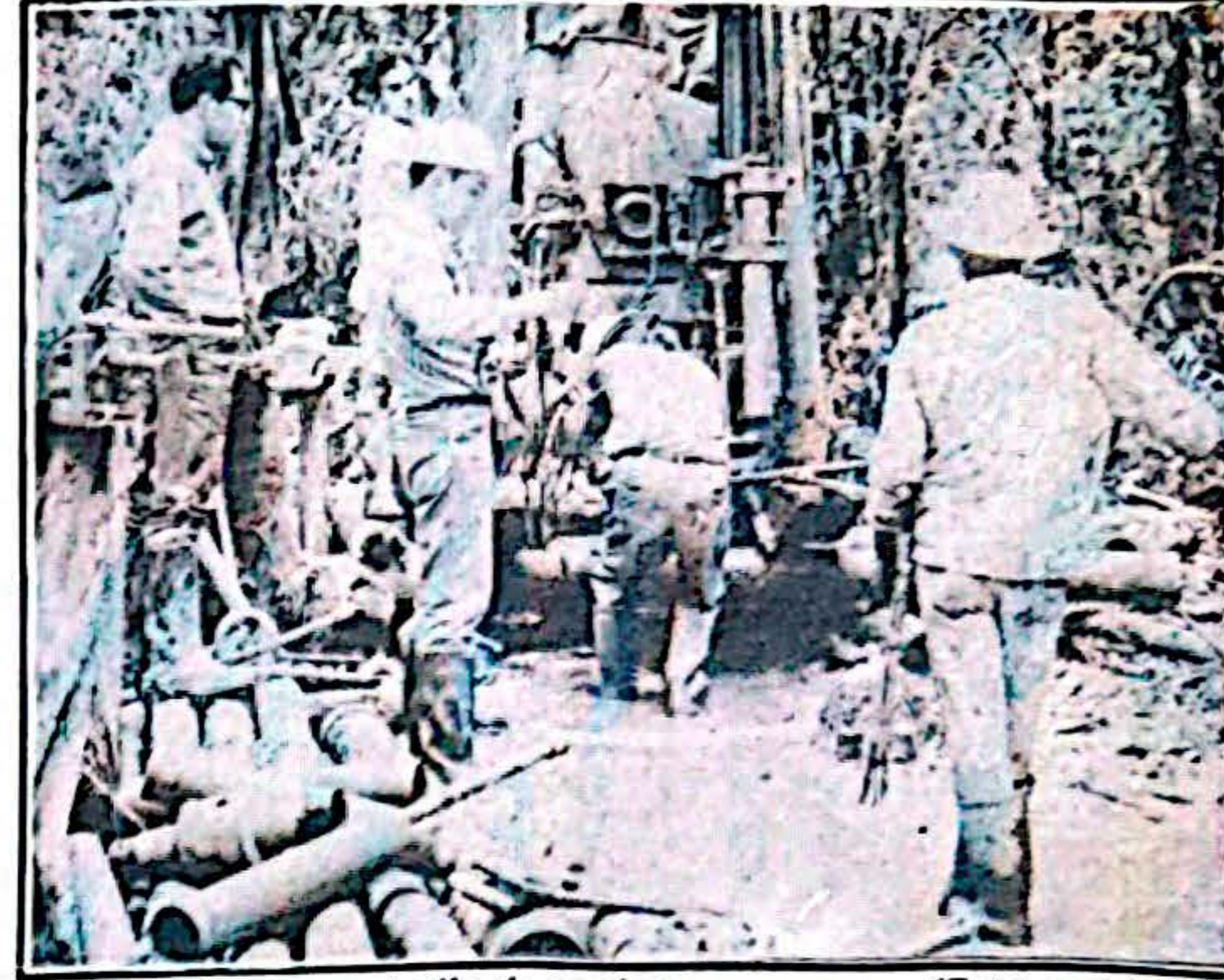
Perforación para estudio de suelos (Foto archivo) Realizado en 1971 por la firma Ingetec-Tams en contrato de la corporación. La hidroeléctrica situada a 50 kms de Buenaventura aumentaría la capacidad nacional en un 50%, y además crearía un lago de nivel controlable que permitiría una explotación racional de la madera, una de las tantas posibilidades que brinda el Chocó energético
