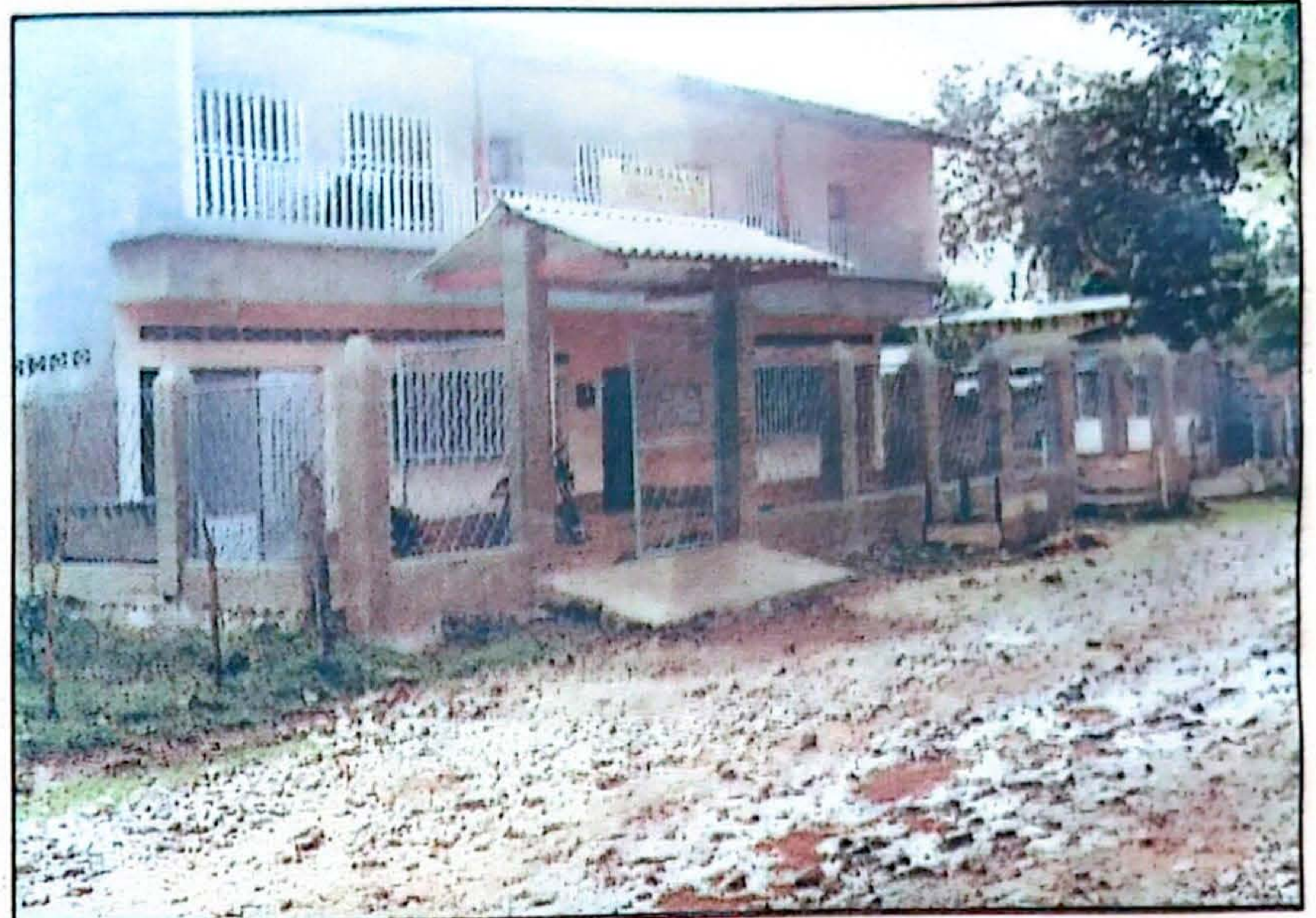
Instalaciones de la Empresa donde se atienden los usuarios. También se inicio la construcción de la nueva sede
