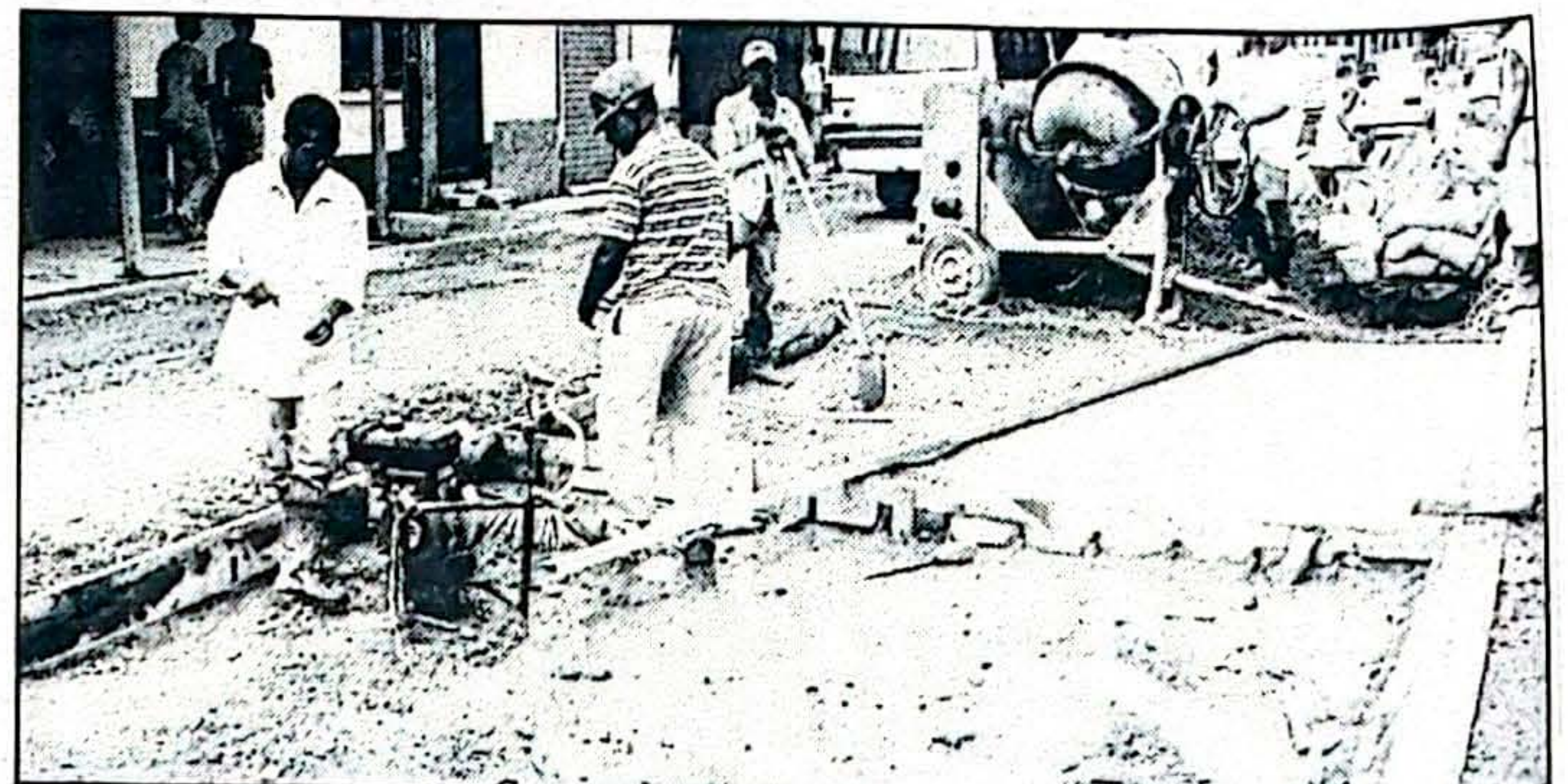
Aspectos de la obra de reparcho de la carrera 7 entre calles 26 y 27 que a la fecha ya presenta sintomas de deterioro
