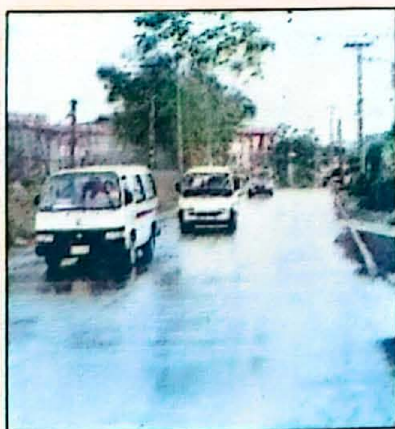
Construcción y pavimentación de la carretera Animas - Quibdó. Accesos a Quibdó
