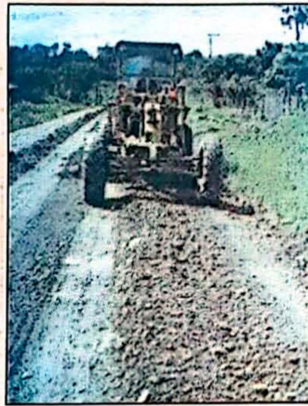
Mejoramiento de afirmado (adición de material de afirmado y conformación mecánica de la banca) en las carreteras Animas - Quibdó y Tadó - Santa Cecilia
