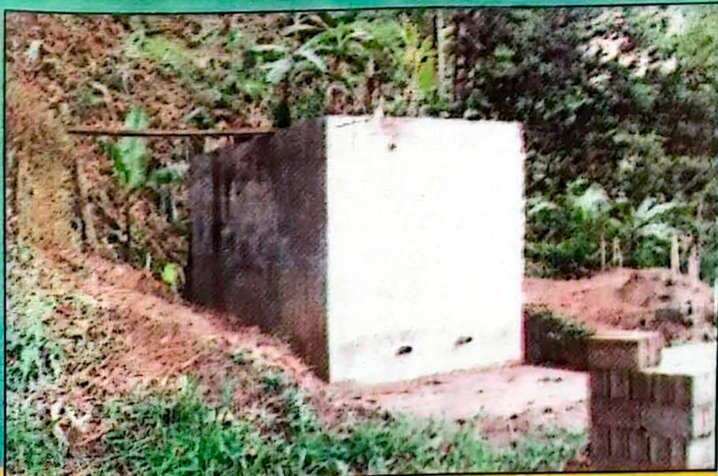
Se construyó el acueducto de la Victoria
