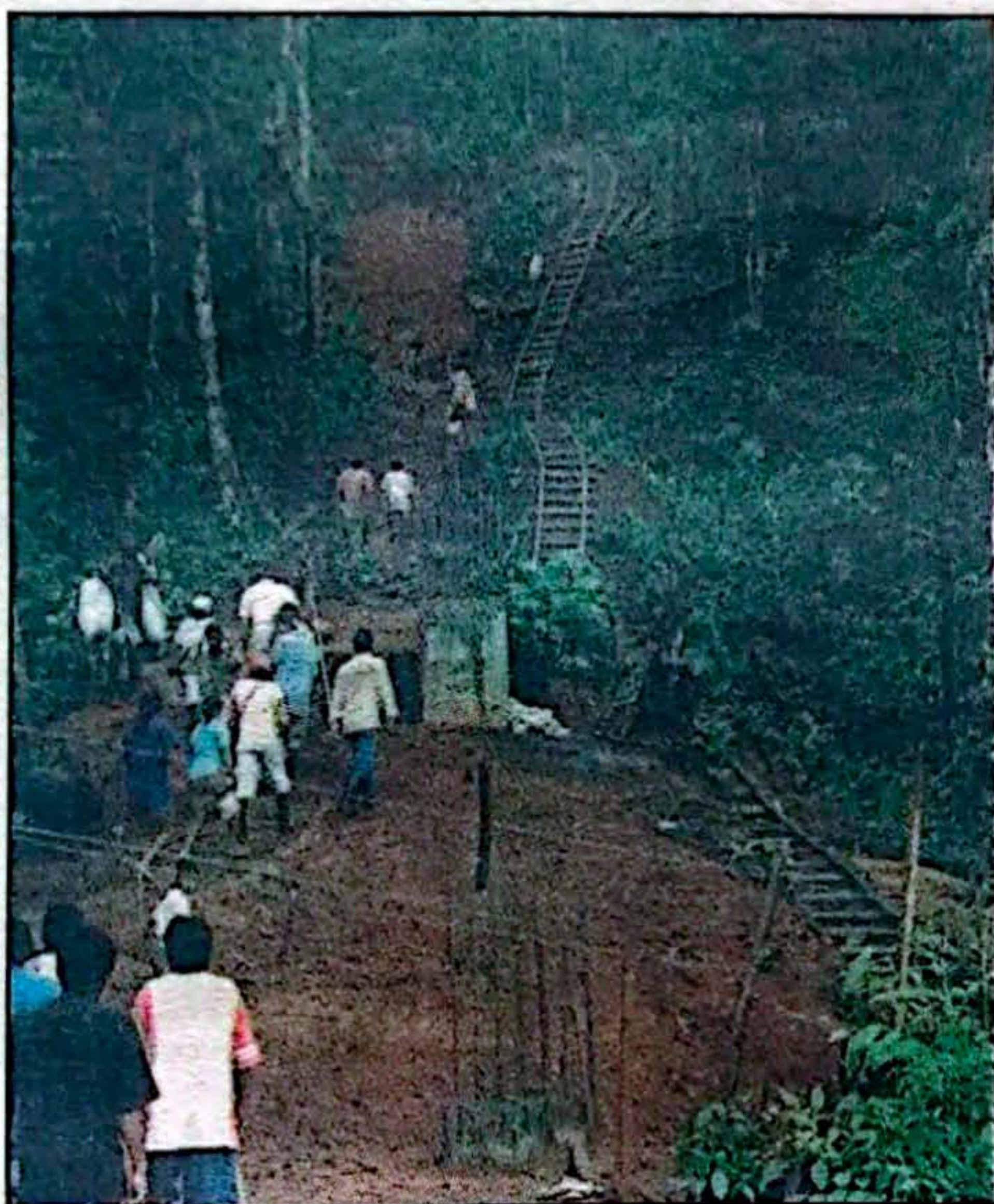
Aspecto de la construcción, rieles de carga y obreros
